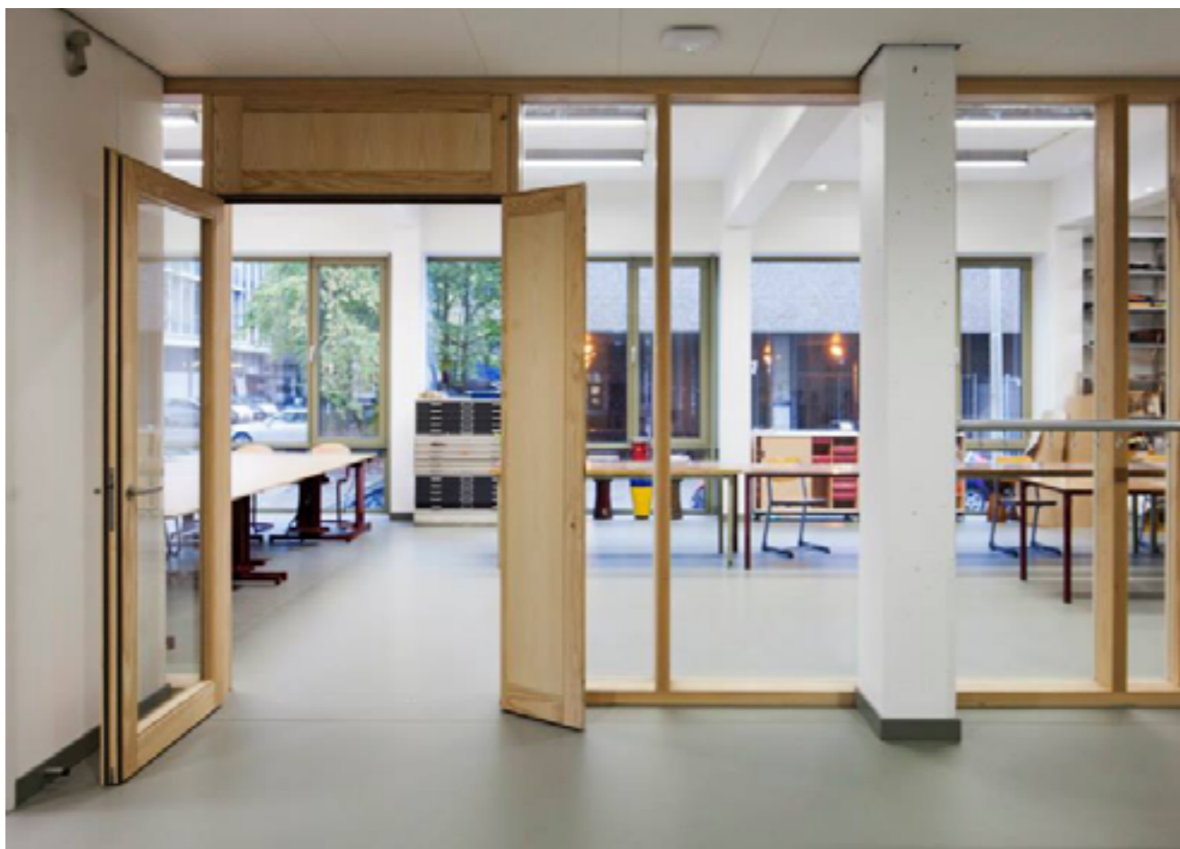
Przeszklenia pomiędzy salami i korytarzem zapewniające dostęp światła dziennego także w korytarzu. Szkoła Podstawowa Het Landje Rotterdam, Holandia; proj. Kortkeknje Stuhlmacher Architecten.
